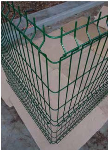
Em casos de cantos arredondados, dependendo do ângulo, não é necessário fazer a dobra do painel - basta cortar o fio que compõe o vinco e fazer a instalação. O painel se ajustará à curvatura.
