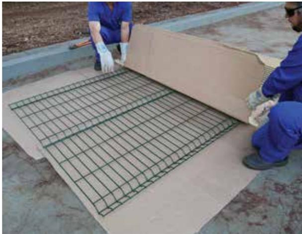
Se preferir utilizar um sarrafo de madeira, ele deve ser maior do que o painel, e precisa ter uma proteção de papelão entre o sarrafo e o painel. Firme as extremidades do sarrafo no chão (sem pisar no painel) e puxe as extremidades do painel para formar a dobra.
