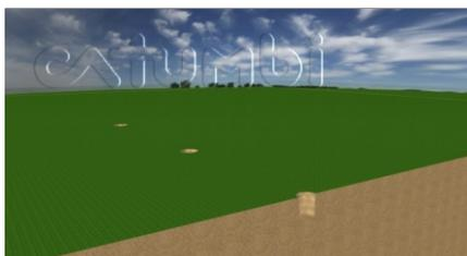
1 Marque os pontos onde serão fixados os mourões (postes de concreto, madeira, tubo galvanizado ou perfis). Cave buracos com pelo menos 50 cm de profundidade a uma distância de 2,00 a 2,50m.
