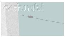
Você também pode substituir o esticador pela catraca com gancho, a principal vantagem é que você acaba tendo um curso maior, o que simplifica a montagem, além que o cabo de aço é preso direto na catraca não sendo necessário o uso do clips.
