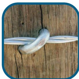
O grampo deve ser fixado na diagonal, permitindo uma folga mínima ao arame, conforme mostra a foto – isto proporciona maior resistência à cerca, e evita que o grampo force o arame provocando uma ruptura da cerca neste ponto.
