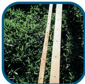
Após a preparação dos cantos, o balizamento e o posicionamento dos mourões intermediários deve ser preparado um gabarito. Fure uma ripa de madeira – ela servirá como guia para furar os mourões na posição correta.
