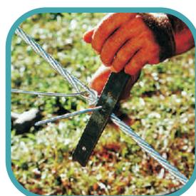
Finalize esta operação recobrimdo e socando os “mortos”, e trançando e arrematando os arames que compõem o rabicho.
