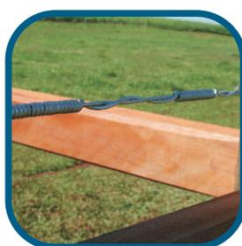
Para obter uma amarração perfeita, comece o arremate com voltas um pouco mais espaçadas, seguidas de voltas mais apertadas. Repita esta operação duas vezes, conforme mostra a foto.
